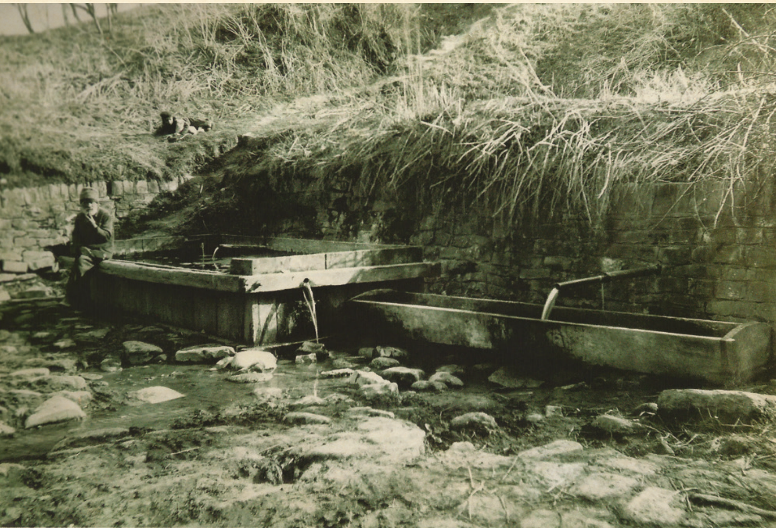
Instalație de captare a apelor la Șipotul Mic (1940) Water pipelines from Șipotul Mic (1940)
